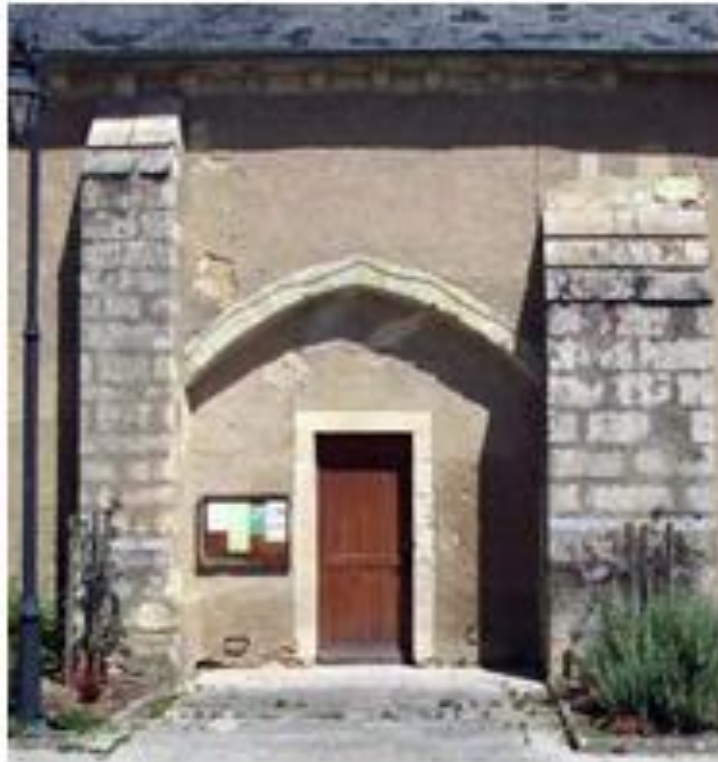
La petite porte de 1910 et l'arc de décharge du XIII e s de l'ancienne porte des morts © DG 2017
